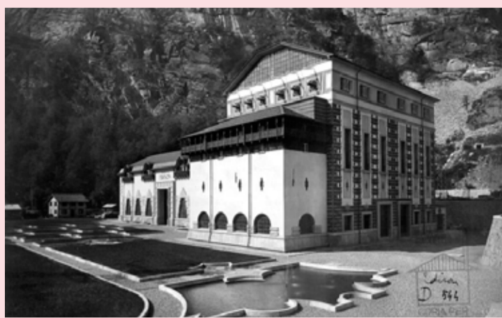
La centrale di Cadarese
